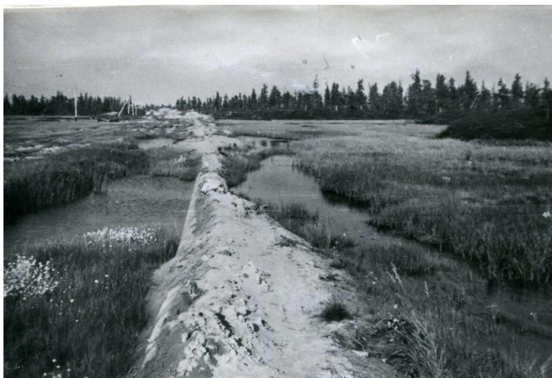
Рис. 2. Техногенные болота и озёрки на трассе магистрального газопровода (фото автора)
