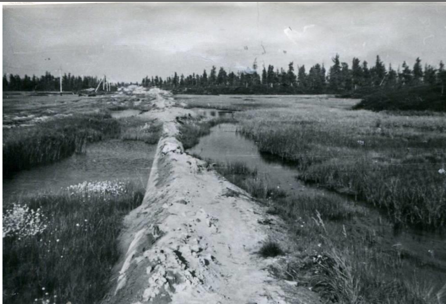
Рис. 1. Заболоченный участок трассы газопровода Надым-Пунга (фото автора)
