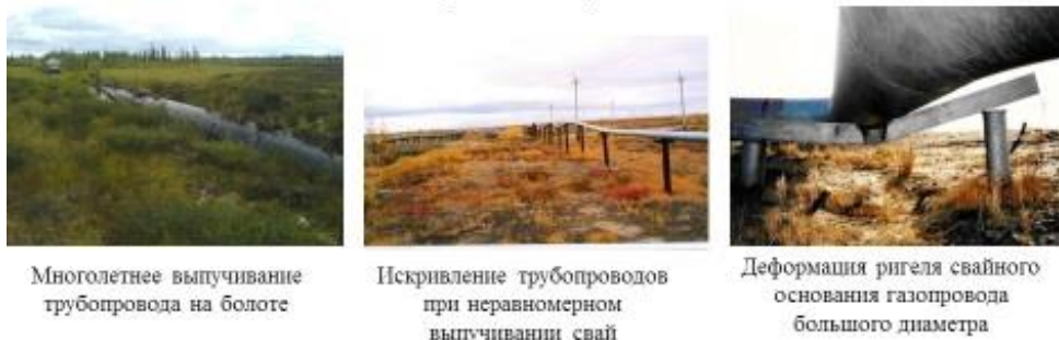
Рис. 10. Результаты воздействия опасных процессов на газопроводы
