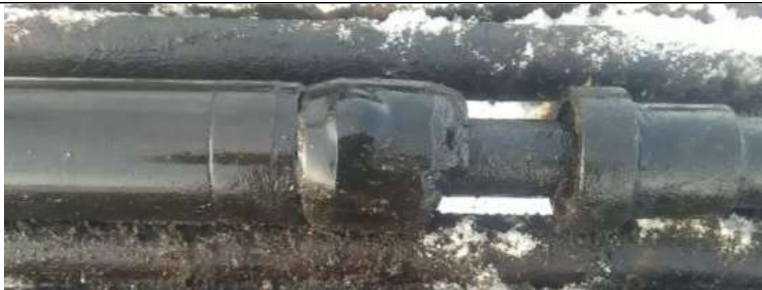
Рисунок 3 Разрушение резиновой манжеты пакерной системы
