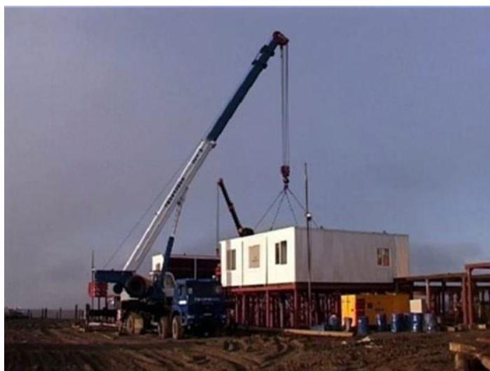
Рис.3 . Комплекс «Северный клевер» в стадии строительства.
