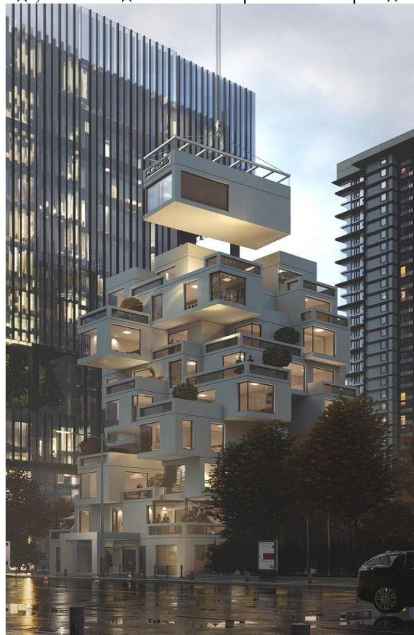
Рисунок 5. Volumetric modular construction. Пример.
